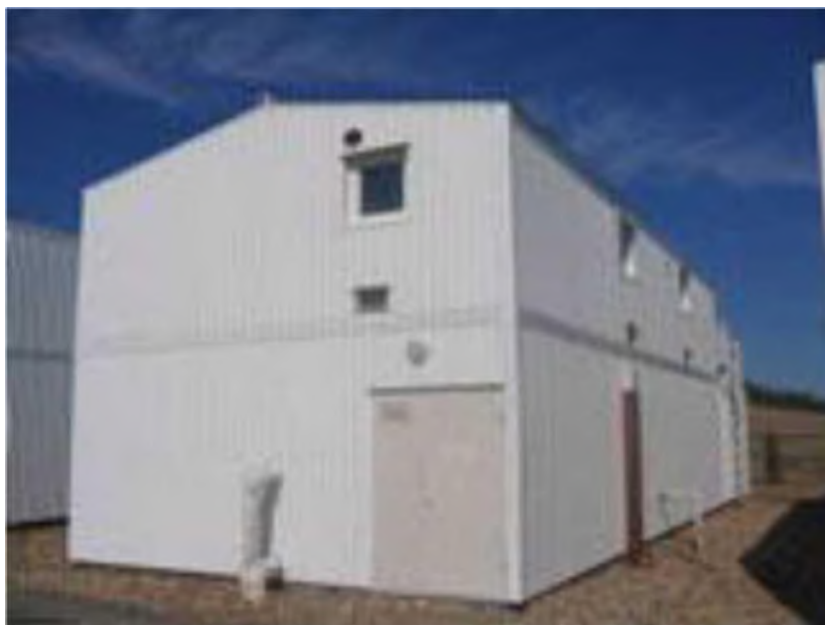
Рисунок 3.3.1.1. Внешний вид очистных сооружений «Биоресурс»
