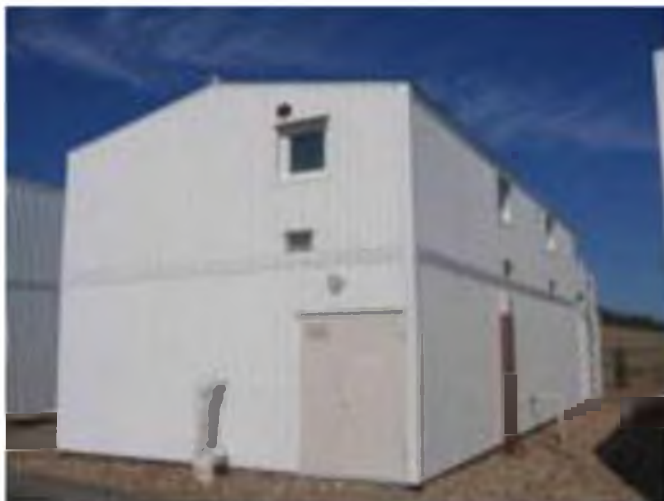
Рисунок 3.3.1.1. Внешний вид очистных сооружений «Биоресурс»
