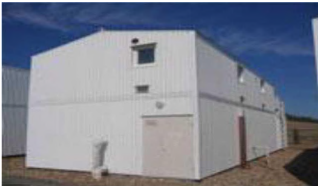
Рисунок 3.4.1.1. Внешний вид очистных сооружений «Биоресурс»
