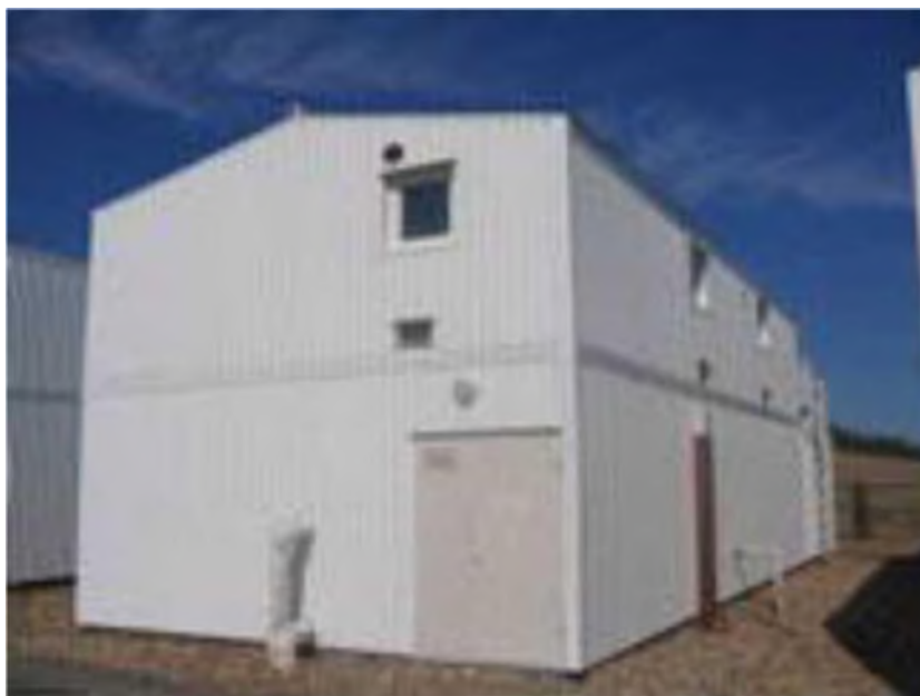
Рисунок 3.4.1.1. Внешний вид очистных сооружений «Биоресурс»
