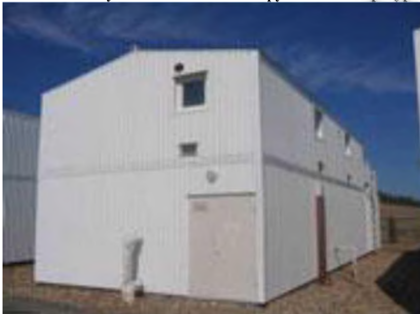
Рисунок 3.4.1.1. Внешний вид очистных сооружений «Биоресурс»
